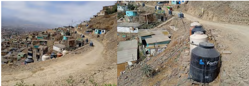
Situación de riesgo previo al inicio de la ejecución del proyecto.
