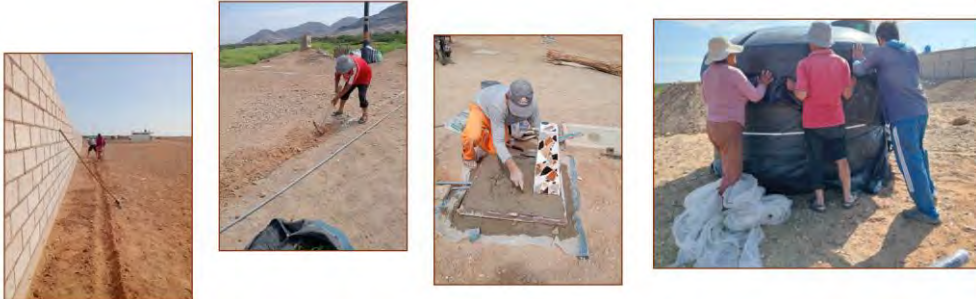
Excavación de zanjas para la instalación de tuberías con el apoyo de la población Construcción de las piletas en zonas estratégicas y ubicación de tanque para su instalación.
