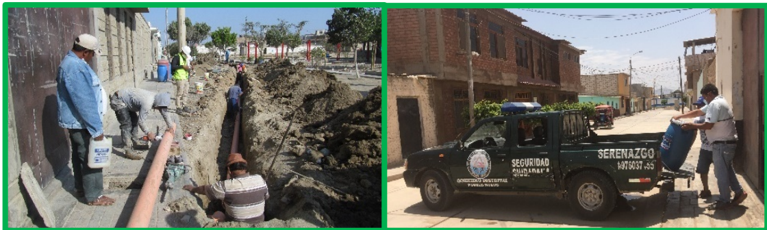
Mejoramiento de redes de alcantarillado -Cetpro
